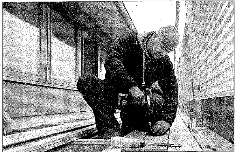
Bauarbeiten an neuen barrierefreien Wohnungen am Niedersedlitzer Platz: Andreas Zeiler bringt Holzleisten auf Terrassen an.
