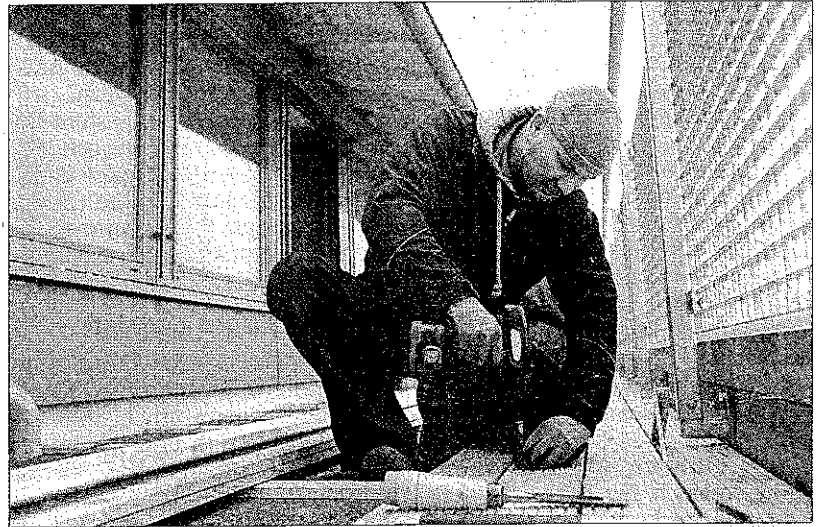
Bauarbeiten an neuen barrierefreien Wohnungen am Niedersedlitzer Platz: Andreas Zeiler bringt Holzleisten auf Terrassen an. Foto: Karl-Ludwig Oberthür
